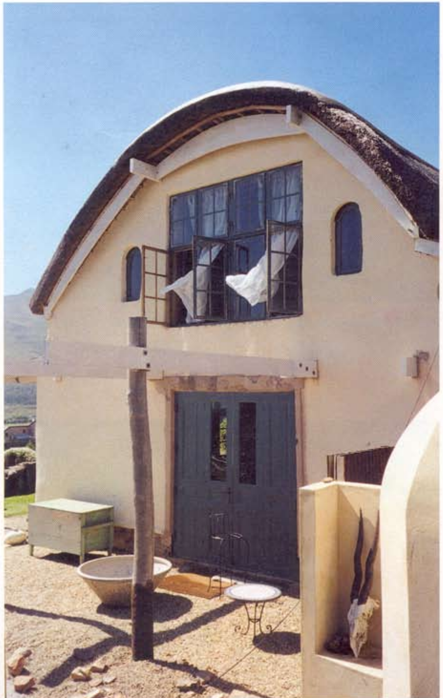
Die Vorhänge zeigen den gewünschten Lüftungseffekt.
