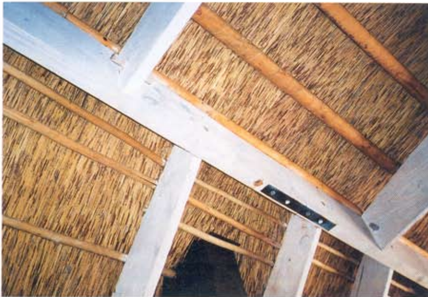
Die in Südafrika klassische Dachkonstruktion mit Stroh und Bambus.
